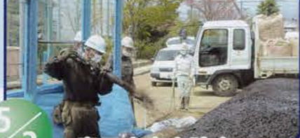
5/3 富田小表土除去
