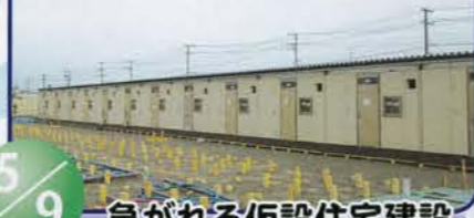
5/9 急がれる仮設住宅建設
